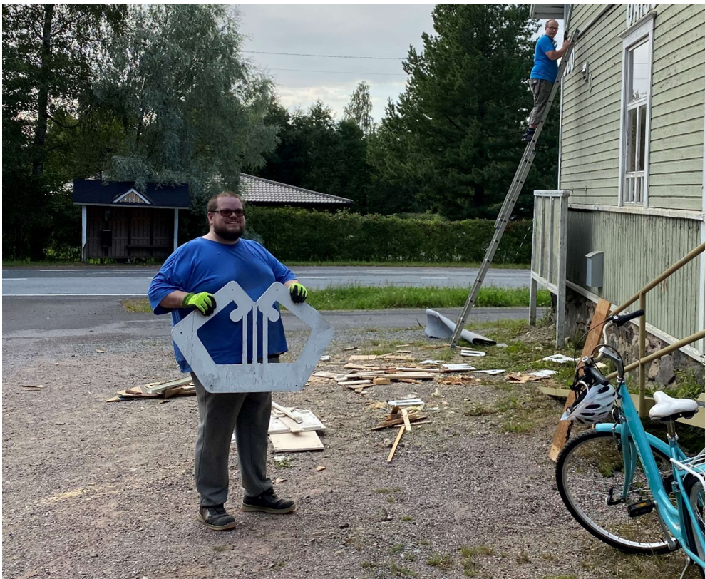
Matilla käsissään Nuorisoseuran merkki, joka jouduttiin väliaikaisesti irrottamaan Nuorisoseurantalon seinästä. Merkki on tallessa ja asennetaan uudelle paikalleen.
